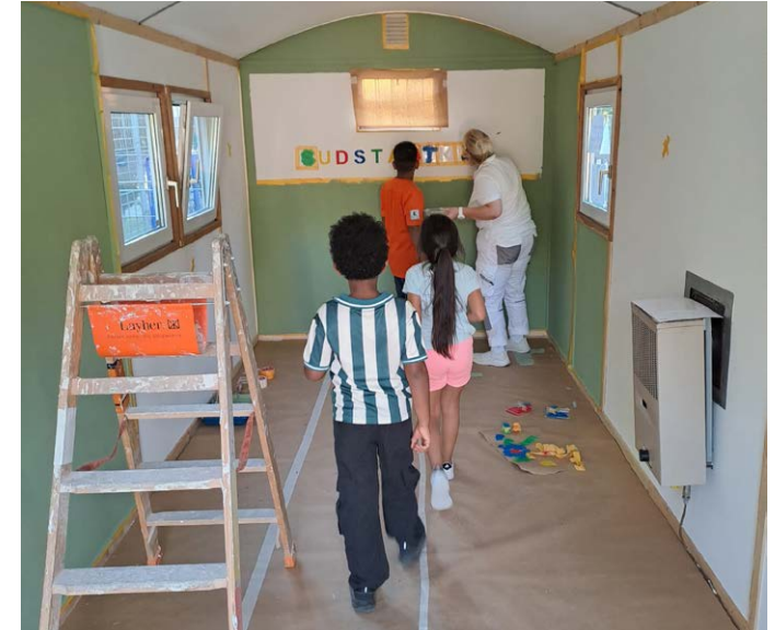
Gemeinsam wurde der Bauwagen renoviert.
